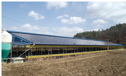
축사 설치 ③
