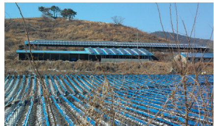
축사 설치 ④
