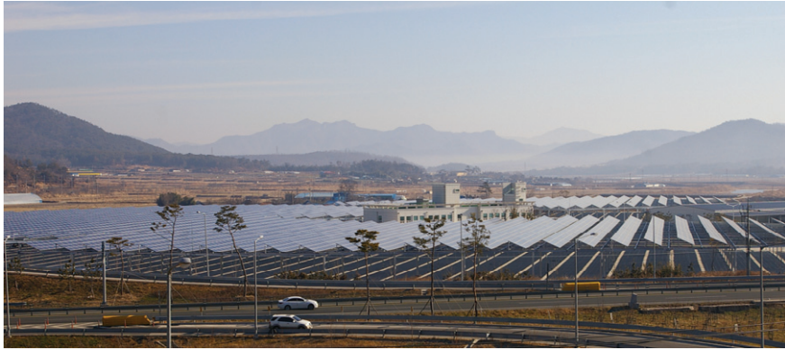
강진군 화물터미널 태양광발전소
