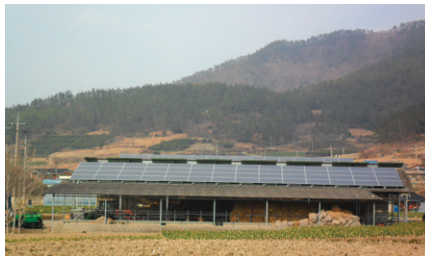
축사 설치 ①
