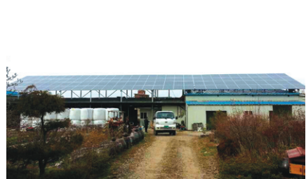
축사 설치 ②
