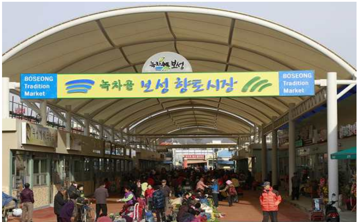
공사완료 후 전경
